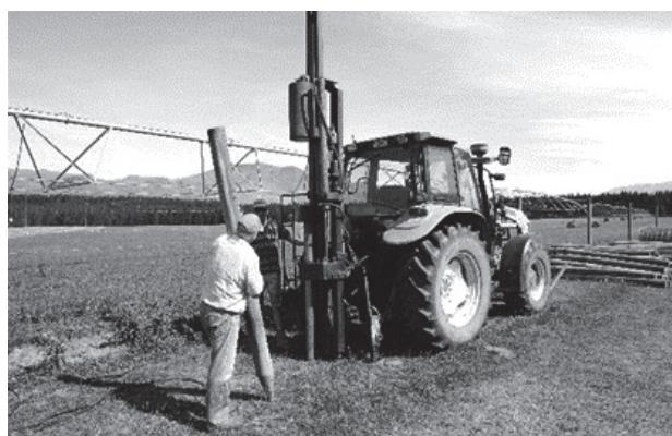
図8. 木柱と杭打ちトラクター
