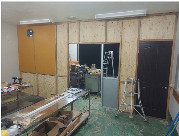
図15 柱と梁をベニア板で覆う
