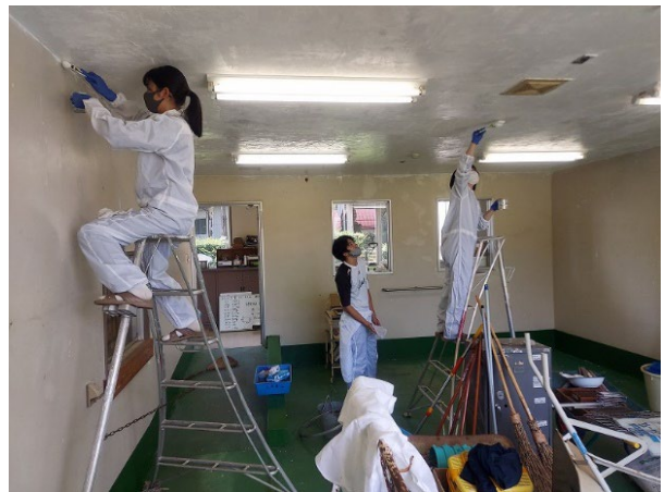
図11 2021年8月30日～天井ペンキ塗り
