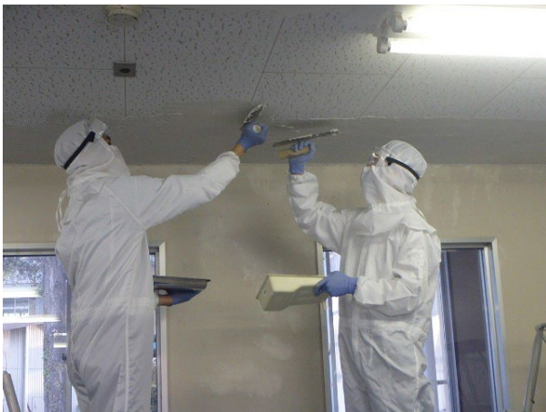
図10 2021年4月23日 天井のパテ埋め作業 できる時に少しずつ行っていたので、来る日も来る
