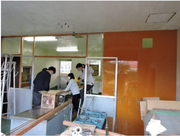
図14 12月10日 吊り戸の設計・取り付け
