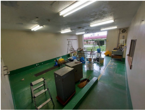
図18 BEFORE (2021年8月17日天井パテ埋終了時)
