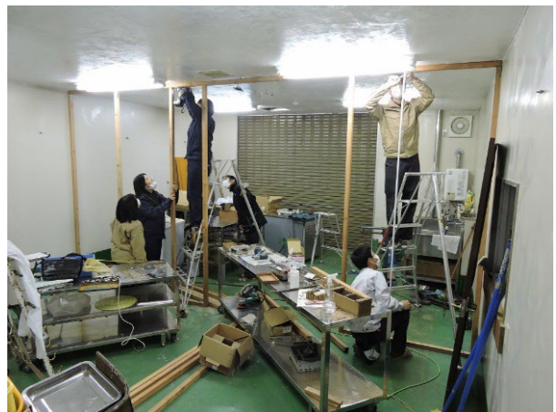
図12 2021年12月3日～梁と柱の取り付け
